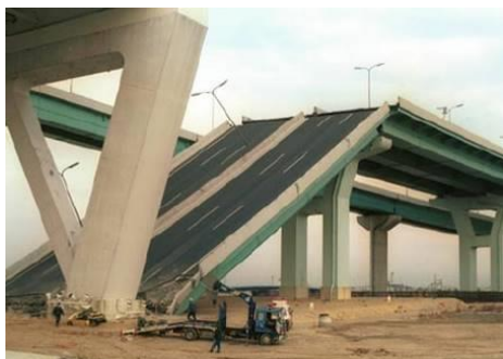
Рис. 3. Обрушение пролета подхода к мосту Нишиномия-ко при землетрясении Хёго-Кен-Нанбу в 1995 году [Собрание Кобе, Библиотека EERC, Калифорнийский университет, Беркли]
