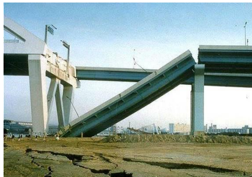
Рис. 3. Обрушение пролета подхода к мосту Нишиномия-ко при землетрясении Хёго-Кен-Нанбу в 1995 году [Собрание Кобе, Библиотека EERC, Калифорнийский университет, Беркли]
